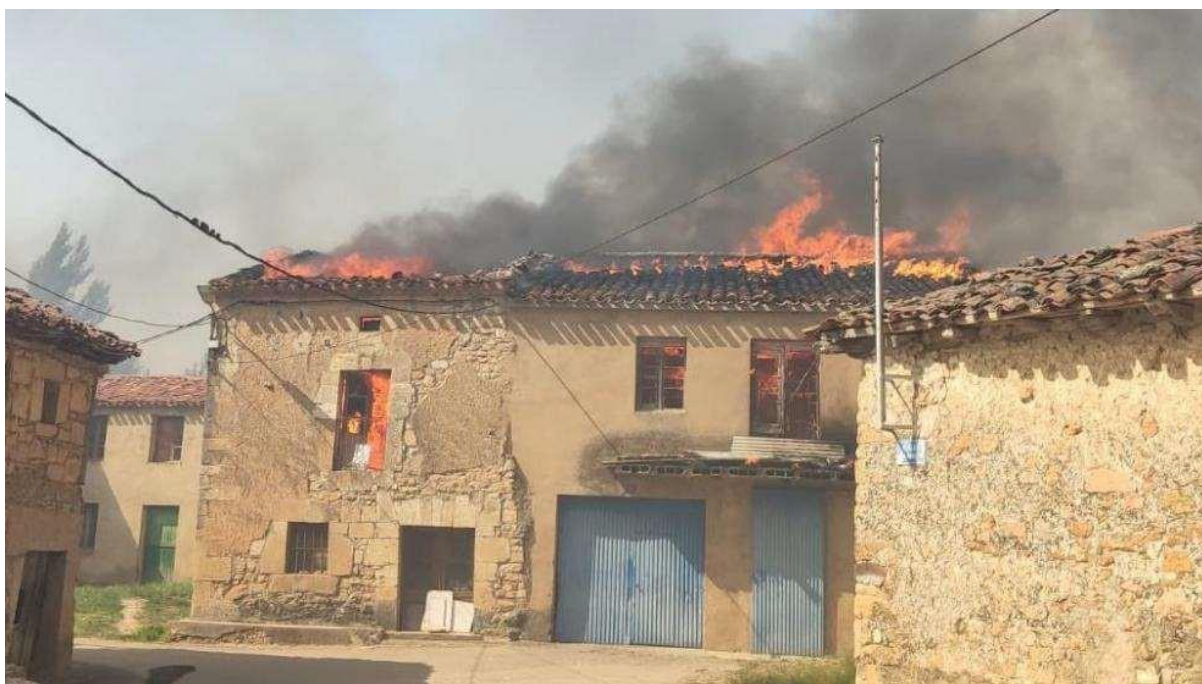
Illustration 3. Incendie d'une maison en juillet 2022 à Quintanilla del Coco, dans la province de Burgos.
